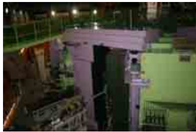
地下 24m のリングサイクロトロン
