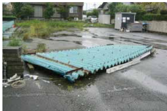
道を隔てた駐車場までとんだ屋根
